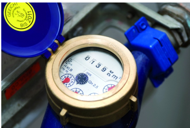
Abb. 1 Ein klassischer Flügelrad-Zähler erfasst im Haushalt die verbrauchte Wassermenge – die Verbrauchs- und Durchflussmessung im industriellen Maßstab erfolgt allerdings immer häufiger mit Hilfe von Ultraschallmessgebern
